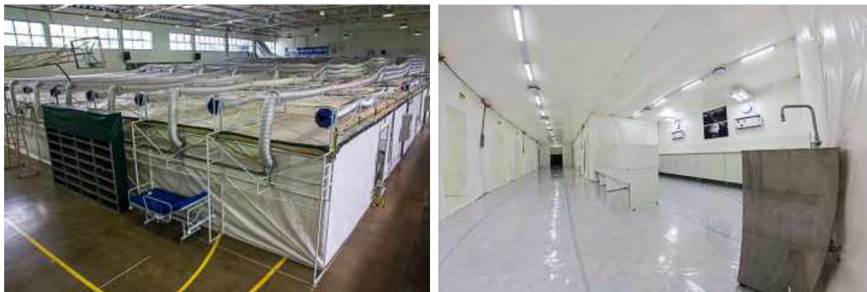
Hospital de Campanha de 84 leitos da EDS em Campinas, entregue no dia 6 de maio de 2020
